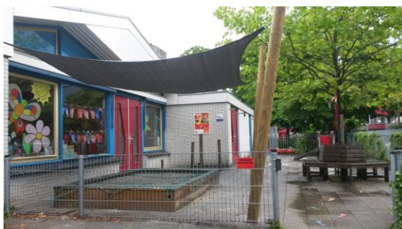
Locatie Pukkie, Hoogeveen
